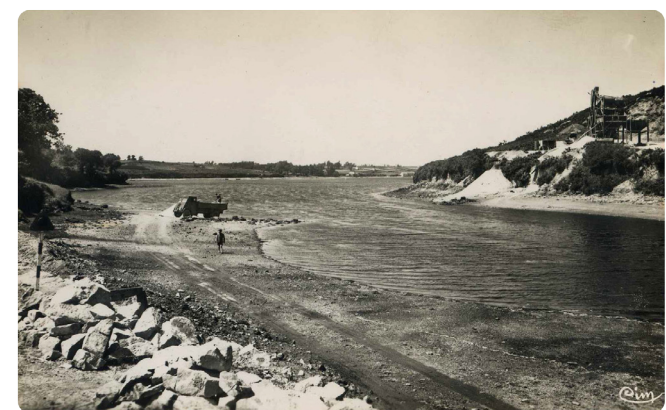
Loc-Majan, carrière Kerleroux.
