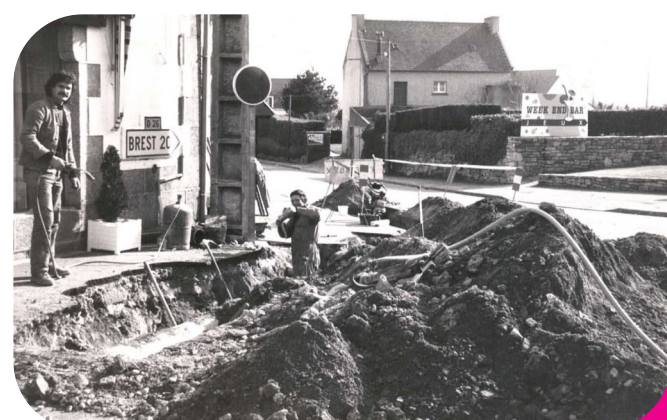
Travaux dans le bourg
