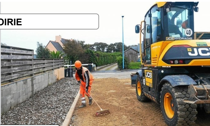
Travaux rue du Stade
